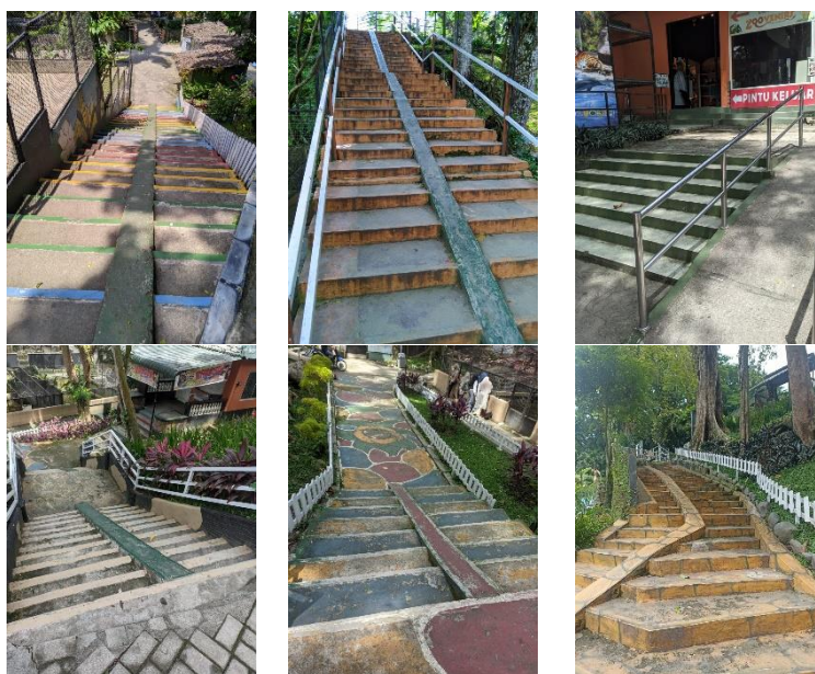
Gambar 1 Kondisi Tangga di Taman Hewan Pematang Siantar
