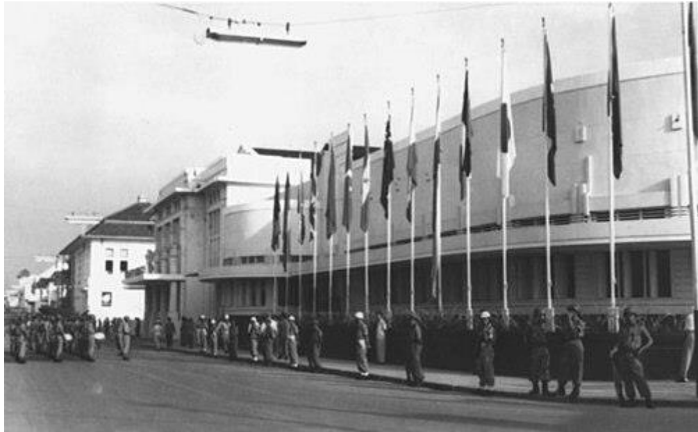
Gambar 1. 1 Gedung Merdeka Bandung (1955)
