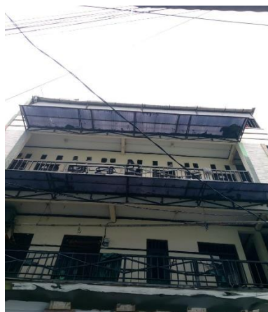
Gambar 1. 3 Bangunan Kusnadi Kost
